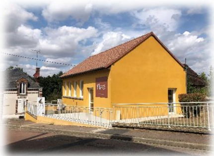
Salle du Tigre Rue du Lavoir
